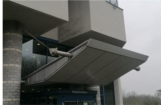
Zeichnen Sie ein mechanisches Ersatzsystem für das Abdach. Die Belastung des Abdaches ist durch sein Eigengewicht gegeben. Achten Sie darauf, dass das mechanische Ersatzsystem durch die Ihnen bekannten Methoden aus der Mechanik I berechnet werden kann. **(3,0 Punkte)**
